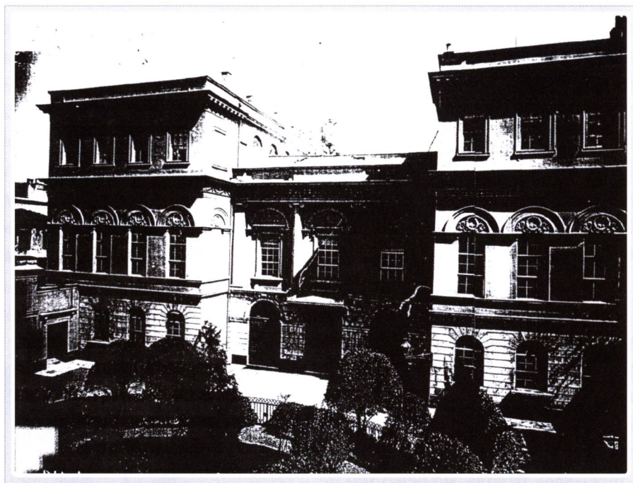
Здание Российского Императорского посольства в Стамбуле.
