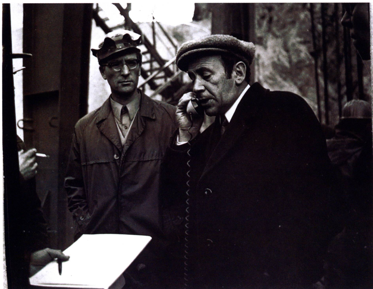
Главный инженер Толкачев дает команду к перекрытию тоннеля Токтогульской ГЭС. 1972 г. (А. Кадыркулов).
