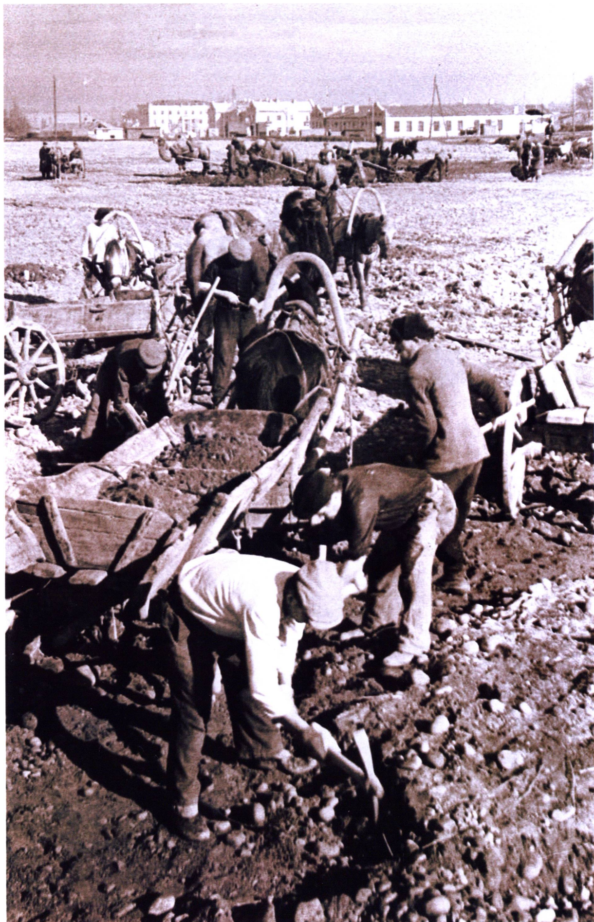
Строительство Большого Чуйского канала (БЧК). 1941 г.
