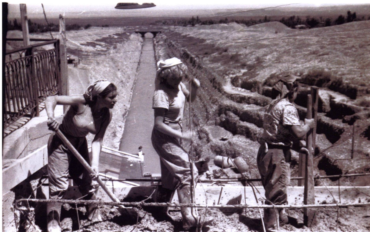
Строители Аламединской ГЭС. 1949 г.
