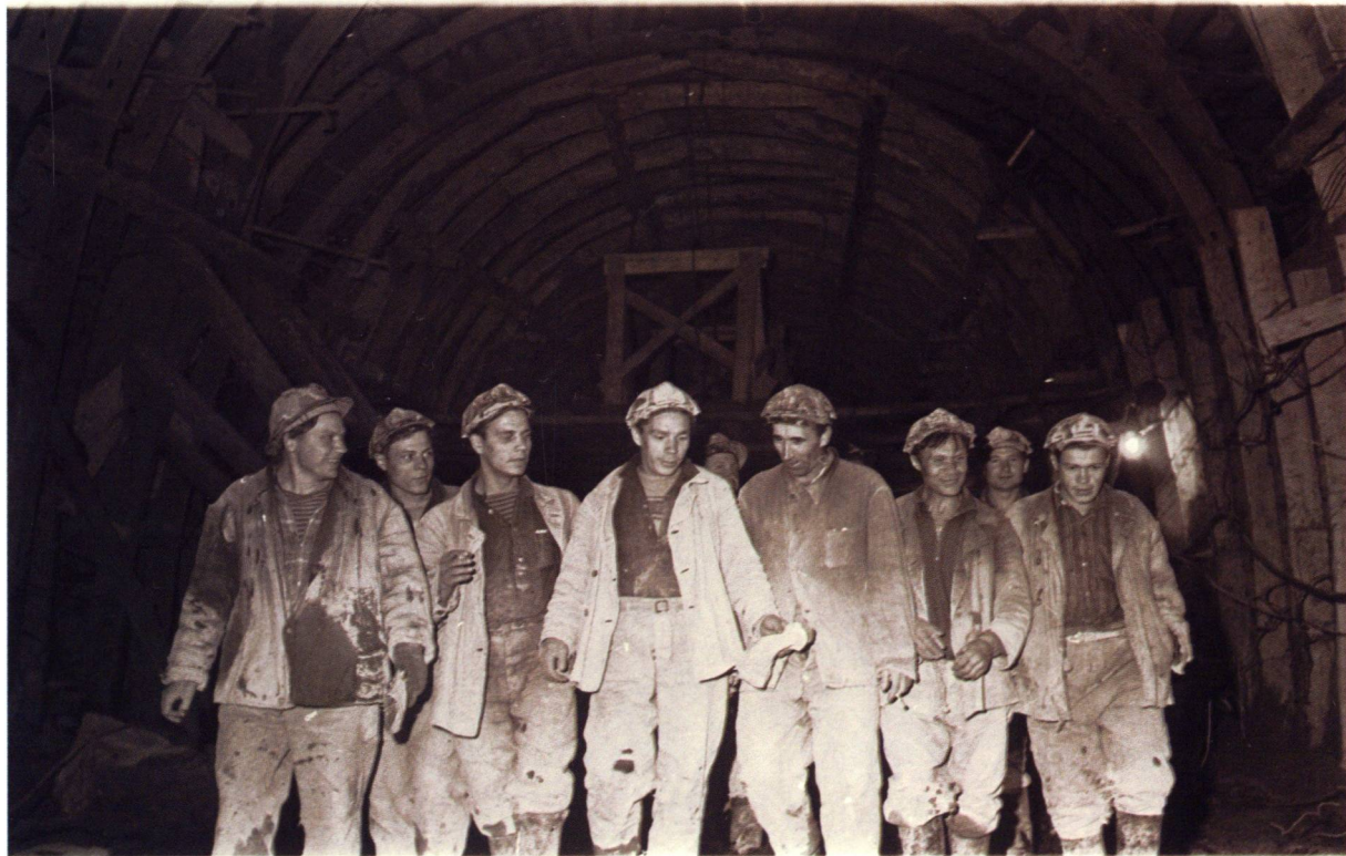
Передовая бригада бетонщиков П. Левченко на строительстве тоннеля под перевалом Тюя-Ашу. 1963 г. (А. Клейменов).
