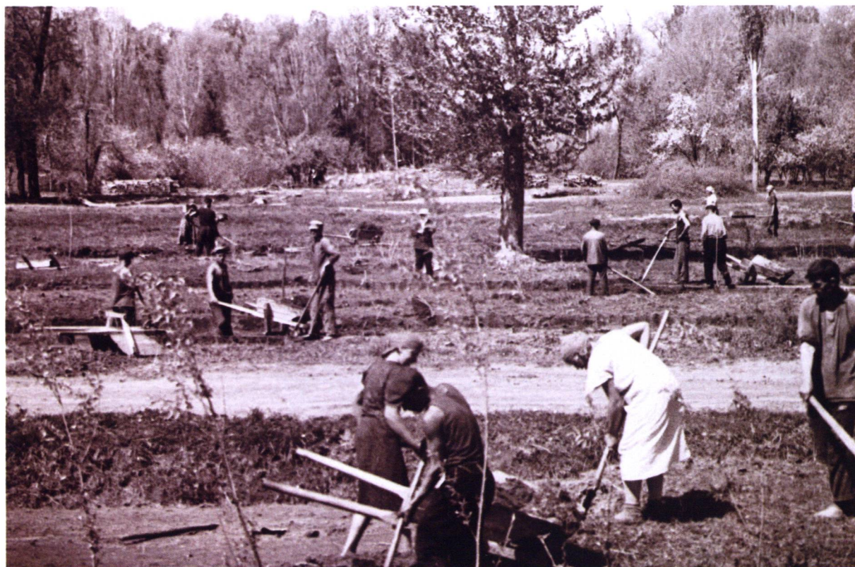
Подготовка к строительству участка БЧК в районе Карагачевой роши, г. Фрунзе. 1941 г.
